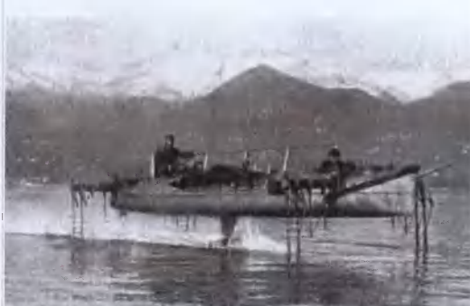
Экспериментальный катер основоположника концепции подводных крыльев Энрико Форланини. Крылья были расположены “этажеркой” (ступенями), и это позволило решить проблему уменьшения площади крыльев с ростом скорости для поддержания постоянной подъемной силы. Во время испытаний на озере Маггиоре катер развил 68 км/ч
