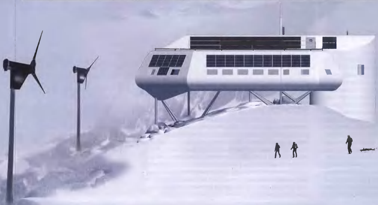
Британская станция Halley VI сможет подниматься по мере роста снежного покрова
