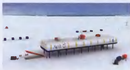
Немецкая станция Neumayer-III будет построена из передовых материалов
